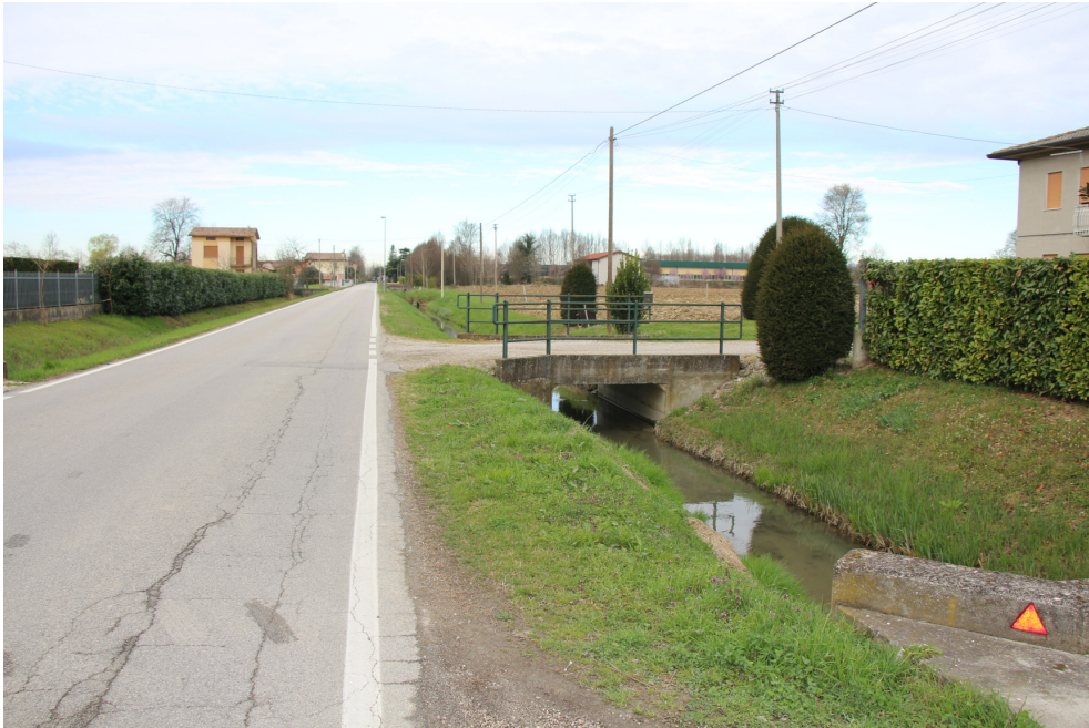
FOTO 1 – Vista Ovest da via Cognaro
