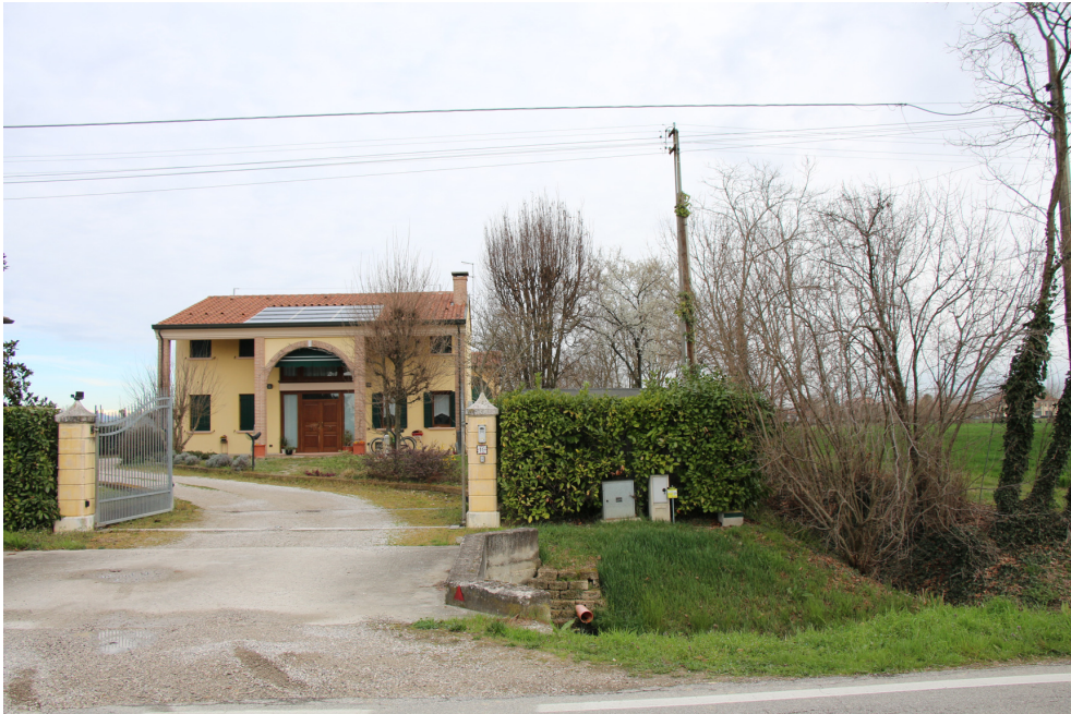
FOTO 3 – Vista prospetto Sud da via Cognaro
